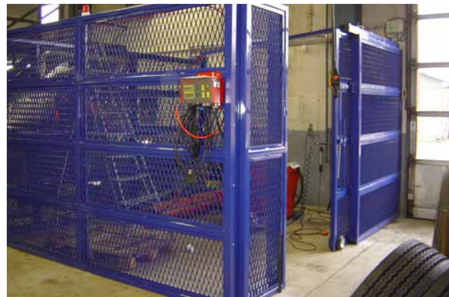
Afb. 54: kooiconstructie waarbij de band op het montageapparaat wordt opgepompt
