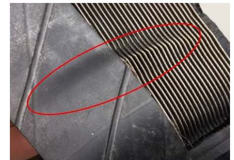
Afb. 7: vervorming duidt op schade aan de kabels.
